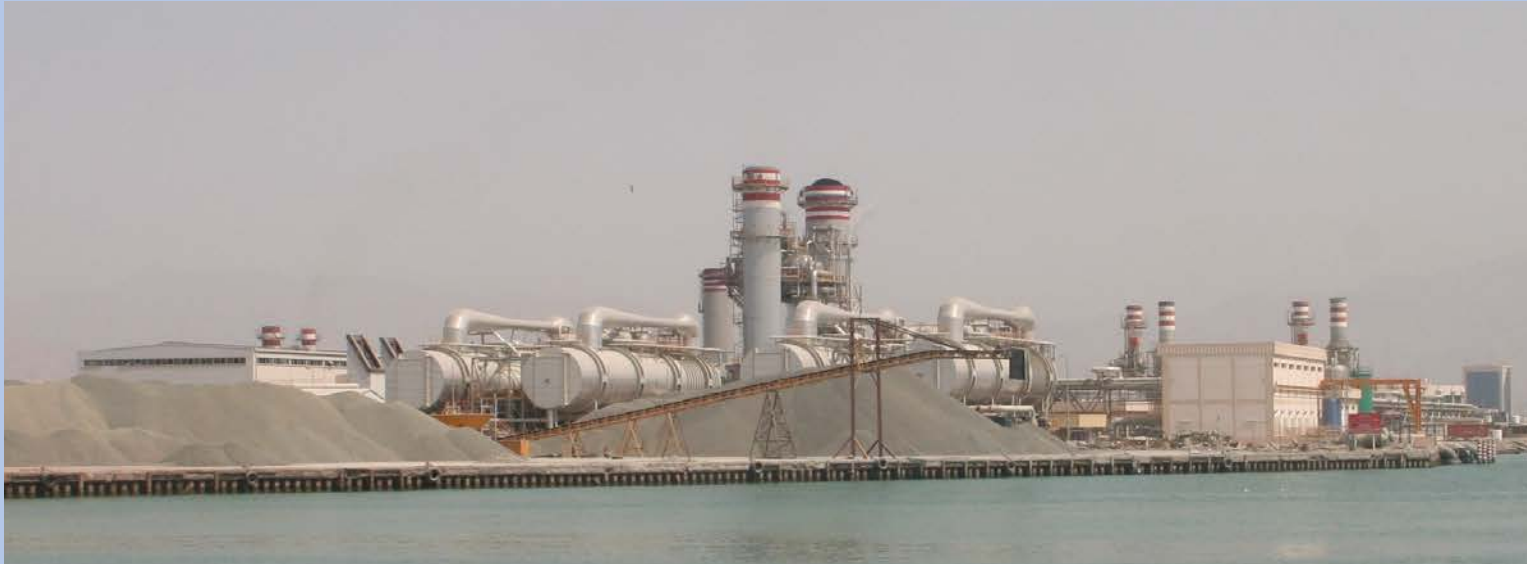
Impianto di desalinizzazione a Ras Al Khaimah, Emirati Arabi Uniti, Octal, CC BY 2.0 < https://creativecommons.org/licenses/by/2.0 >, via Wikimedia Commons
